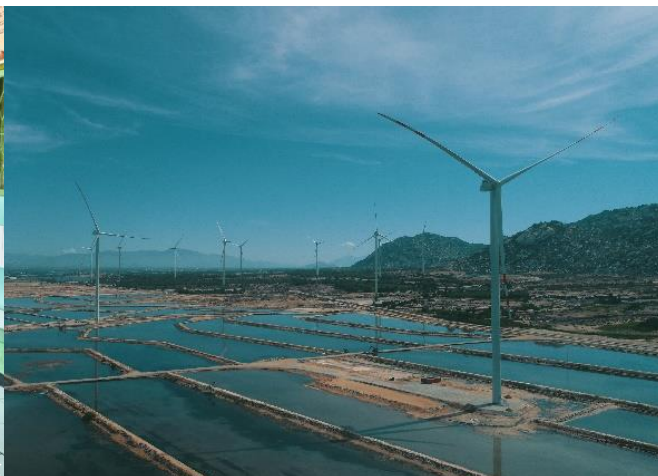
ベトナムの風力発電所建設支援（海外投融資）
